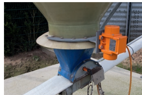
Silo con vibrador eléctrico
